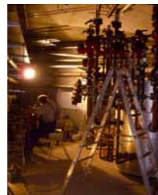
ZORTSTRÖM während der Montage mit mehreren Aufbauten
