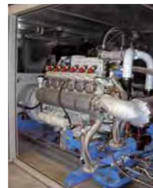
Blockheizkraftwerk
