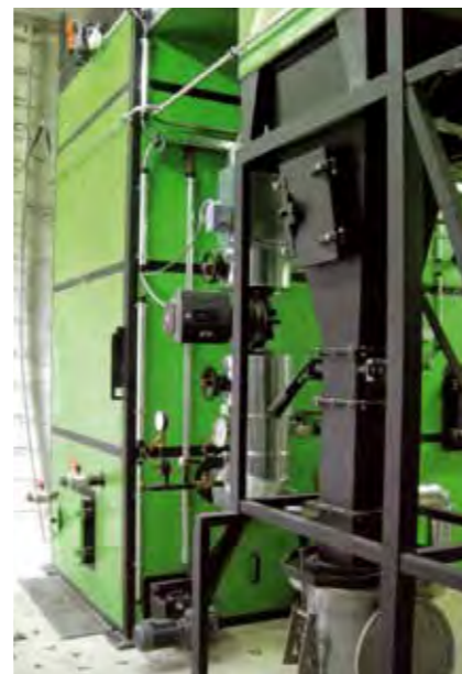
Hackschnitzelkessel 800 kW
