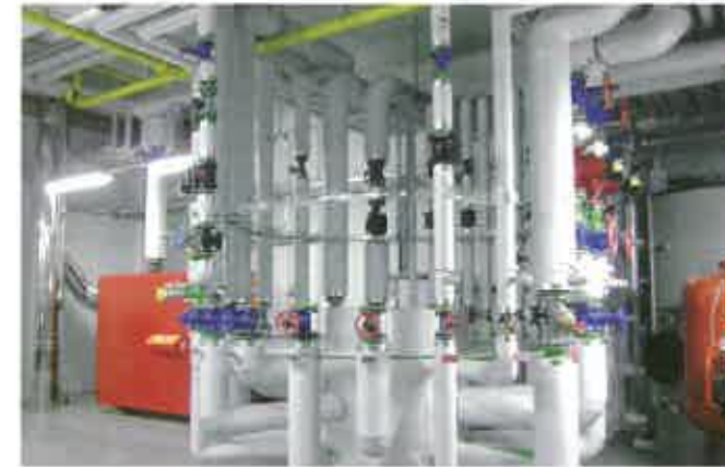
Die stufenweise Temperaturschichtung der Zortström-Technologie versorgt alle angeschlossenen Kreise mit ihren jeweiligen Systemtemperaturen und Massenströmen. Bei entsprechender Vorplanung ergibt sich eine einfache Leitungsführung.
