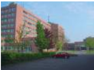
Landratsamt Steinfurt D-48565 Steinfurt
