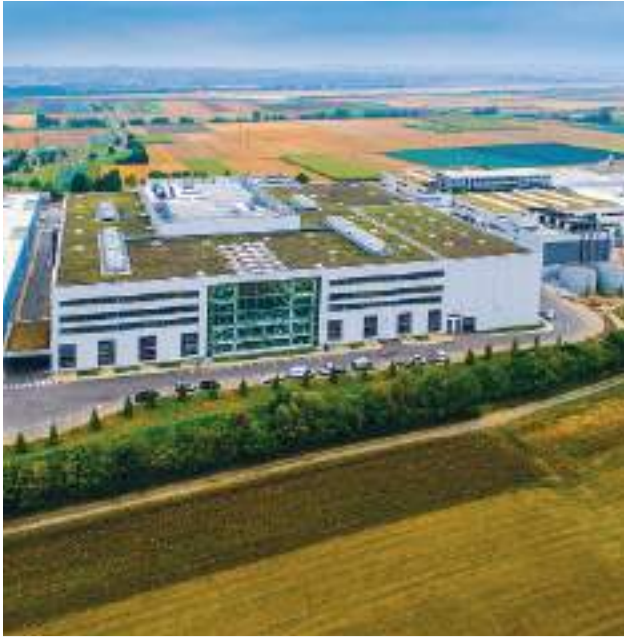
Planung GF-Ingenieurgesellschaft für Gebäudetechnik mbH Ausführung Windmüller Technik GmbH
