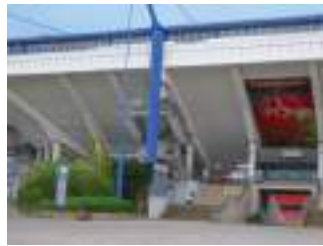
Grundig Stadion FC Nürnberg D-90471 Nürnberg
