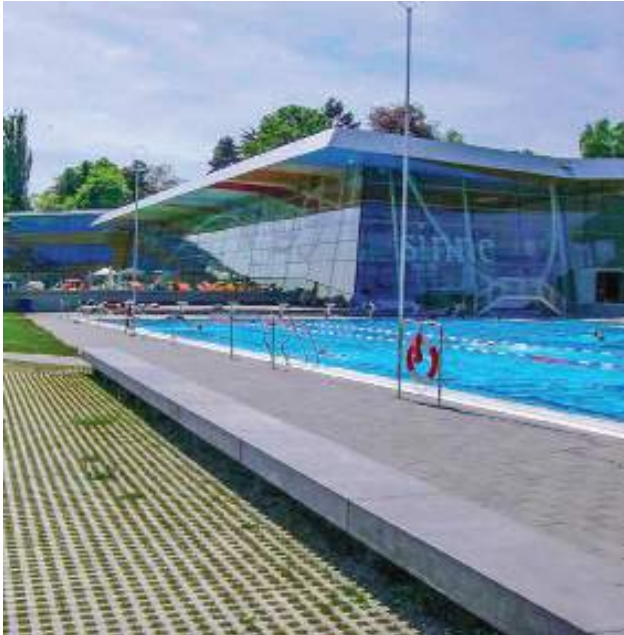
Planung Greiner Engineering Ausführung Imtech Deutschland GmbH & Co. KG
