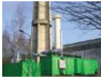
Fernheizwerk Hohenstein D-65329 Hohenstein
