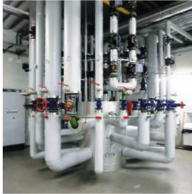
Zortström Multi-H 3-stufig Durchmesser 800 mm
