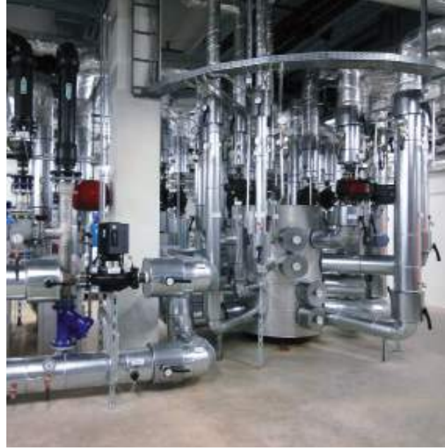
Zortström Multi-HK 4-stufig Durchmesser 1.000 mm
