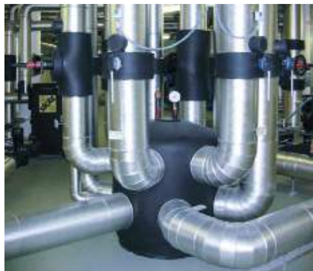
Zortström Multi-K 2-stufig Durchmesser 900 mm
