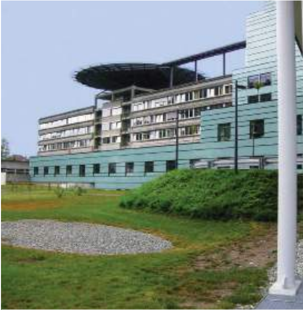
Planung Hightech-Büro Linher Ausführung Intemann GmbH
