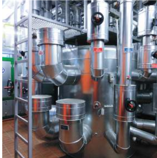
Zortström Multi-H 3-stufig Durchmesser 1.400 mm
