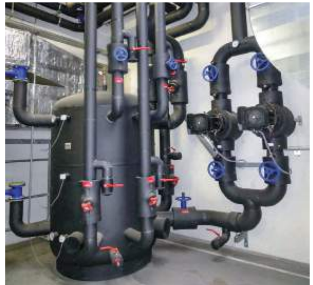
Zortström Multi-PG-K 3-stufig Durchmesser 1.100 mm
