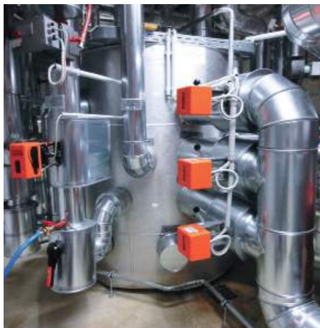
Zortström Multi-K 4-stufig Durchmesser 1.100 mm
