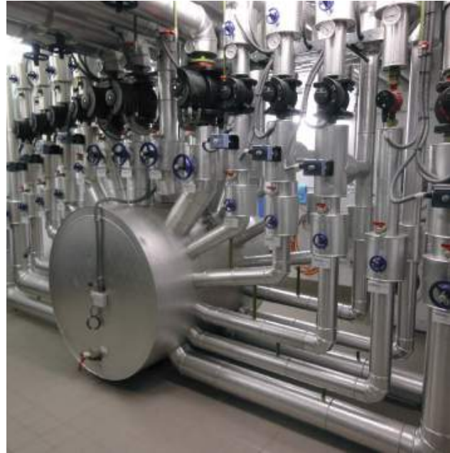
Zortström Multi-H 3-stufig Durchmesser 1.000 mm
