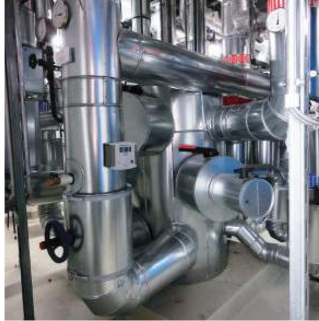
Zortström Multi-K 3-stufig Durchmesser 1.100 mm
