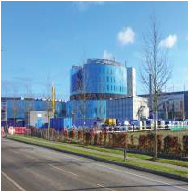
Planung Enerplan GmbH Ausführung Enercret GmbH
