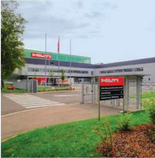
Planung KTO Engineering GbR Ausführung Gebrüder Gassner GmbH
