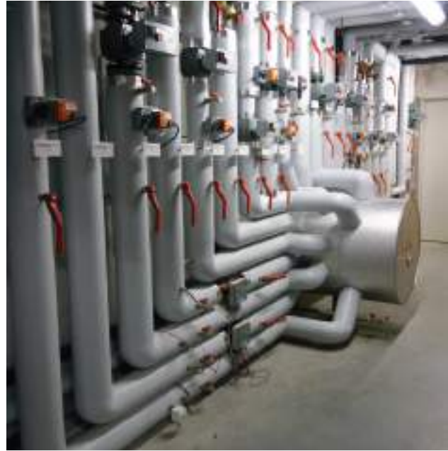
Zortström Multi-H 3-stufig Durchmesser 600 mm
