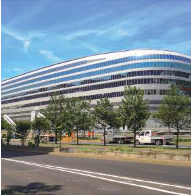
Planung YIT Germany GmbH Ausführung YIT Germany GmbH
