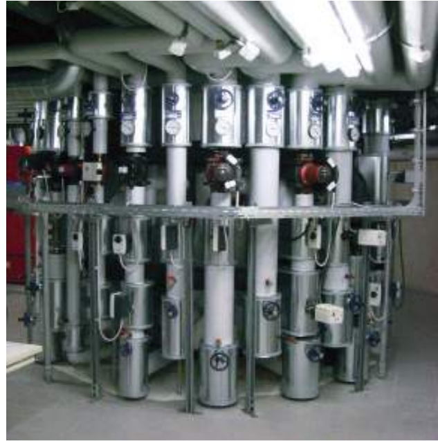
Zortström Multi-H 4-stufig Durchmesser 1.200 mm
