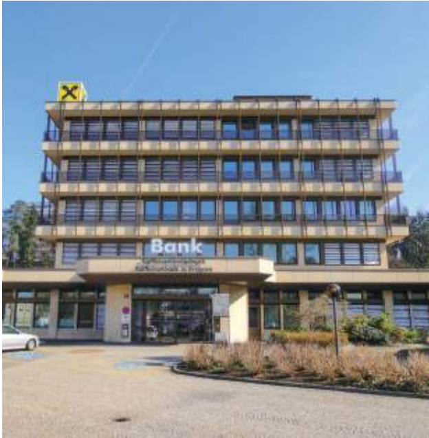
Planung Innotech -innovative Gebäudetechnik GmbH Ausführung Hörburger GmbH und Intemann GmbH
