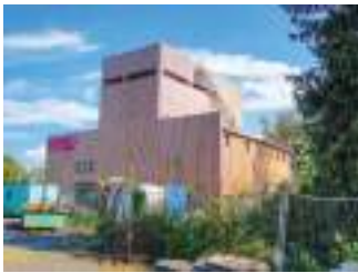
Fernheizwerk Wächtersbach D-63607 Wächtersbach
