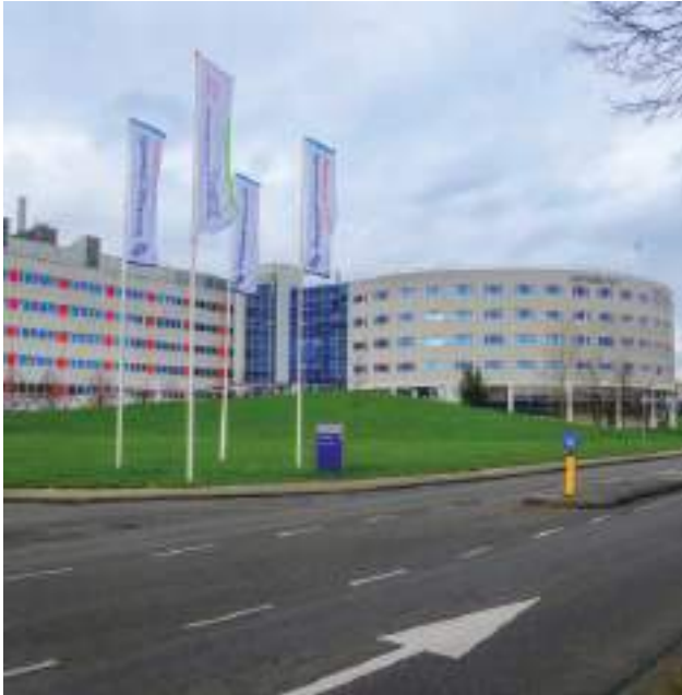
Planung Royal HaskoningDHV Ausführung Academisch Ziekenhuis Maastricht
