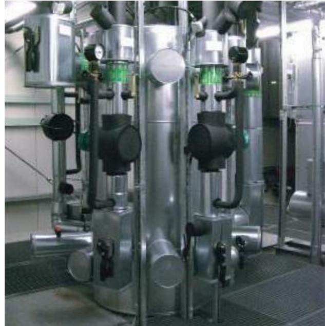
Zortström Multi-PG-K 3-stufig Durchmesser 1.200 mm
