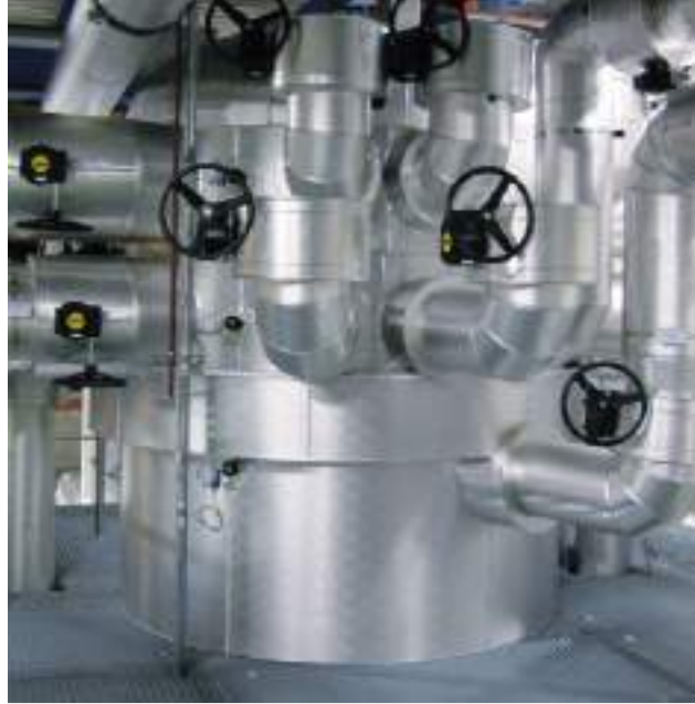
Zortström Multi-K 3-stufig Durchmesser 2.200 mm
