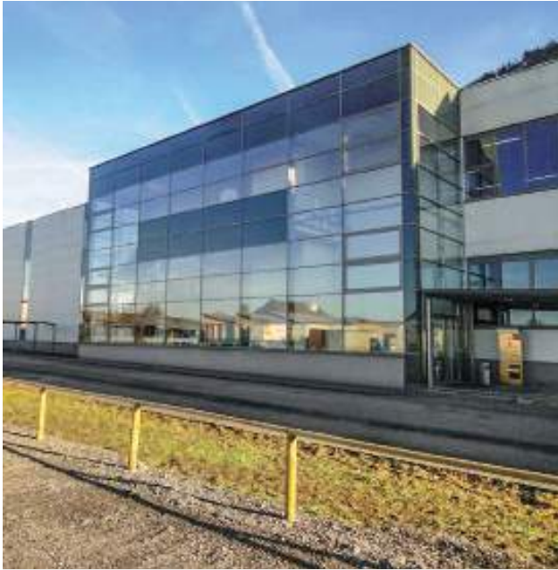
Planung Innotech GmbH & Co. KG Ausführung Berchtold Installationen GmbH
