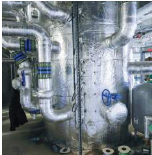
Zortström Multi-PG-H, 3-stufig (Heizung) Durchmesser 2.000 mm
