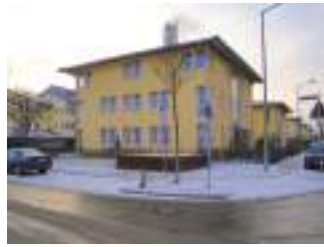
Fernheizwerk Ismaning D-85737 Ismaning
