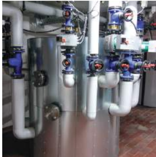
Zortström Multi-H 3-stufig Durchmesser 1.100 mm
