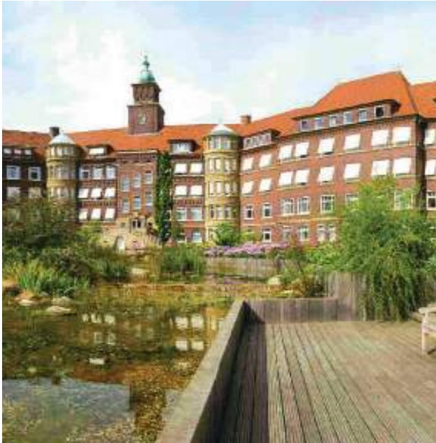
Planung Plancad Planungsteam für Haustechnik GmbH Ausführung Niehaves Versorgungstechnik GmbH
