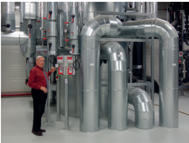
Zortström Multi-H 5-stufig (Heizung) Durchmesser 2.200 mm
