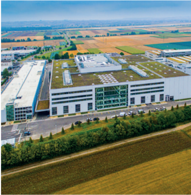
Festo AG & Co. KG Technologiefabrik Scharnhausen Planung: GF-Ingenieurgesellschaft für Gebäudetechnik mbH Ausführung: Windmüller Technik GmbH
