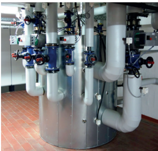
Zortström Multi-H 3-stufig (Heizung) Durchmesser 1.100 mm
