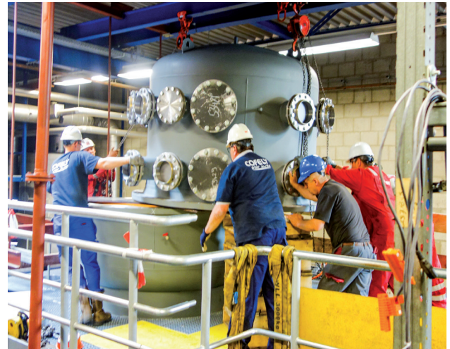
Montage, des in zwei Teilen gelieferten Zortströms
