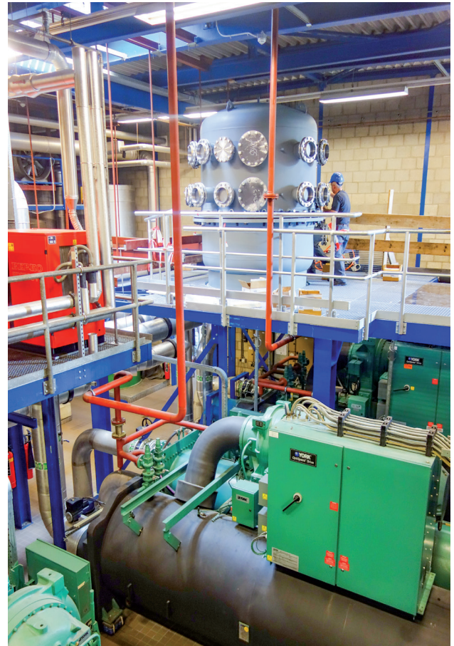
Zortström nach fertiger Montage, vorbereitet für die weitere Installation
