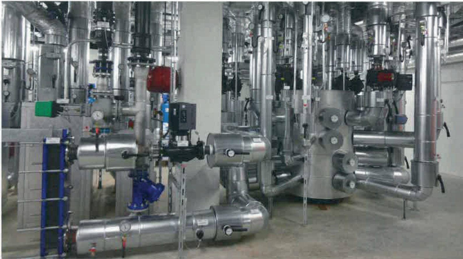
Jedes Zortström-Zentrum arbeitet nach dem Prinzip der hydraulischen Entkopplung. Es wird projektspezifisch sowie mit der benötigten Anzahl von Temperaturstufen geplant und gefertigt.
