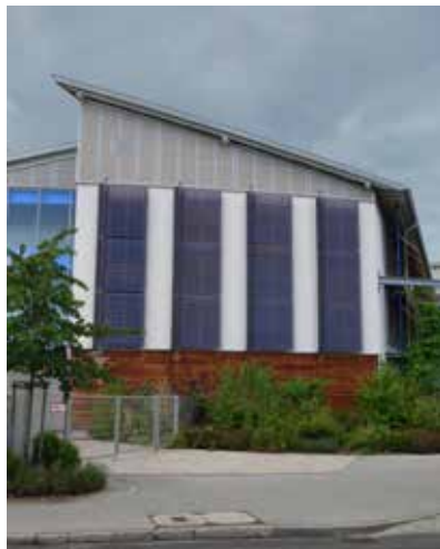
460m 2 Sonnenkollektoren in 4 Sektoren
