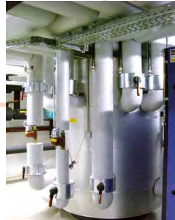
ZORTSTRÖM mit 3 Temperaturstufen 90/70/50°C mit Pufferfunktion
