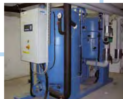
Absorber-Kältemaschine
