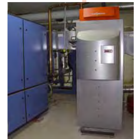
Spitzlastkessel
